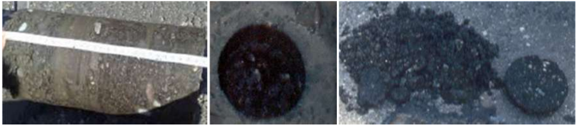
Рис. 4.11. Загальний вигляд кернів на дослідній ділянці автомобільної дороги Львів-Тернопіль (км 60+500 – км 62+700)
